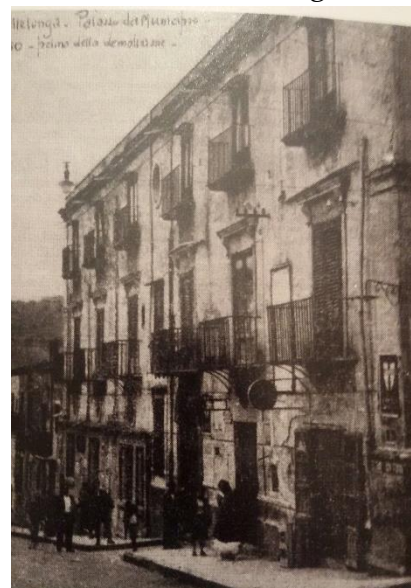
Palazzo De Martino-Audino prima della demolizione del 1956
